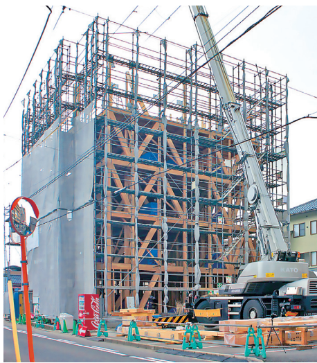
写真 1.3 筋かいによる木造 5 階建て（写真提供：㈱シエルター）
