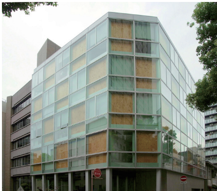
写真 1.2 CLTを耐力壁に用いた 事務所建築（兵庫県林業会館）
