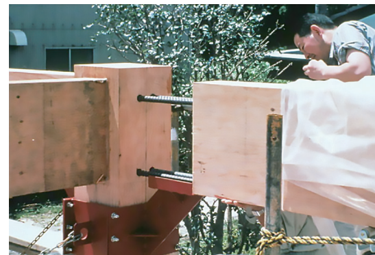
写真 1.4 鉄筋挿入接着工法
