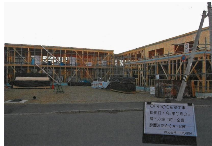
写真 外観写真の例
